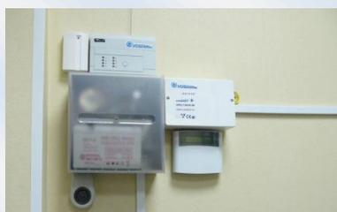
Множество датчиков охранно-пожарной системы в режиме реального времени осуществляют контроль за состоянием здания или помещения и передают собираемую информацию на панель управления.
